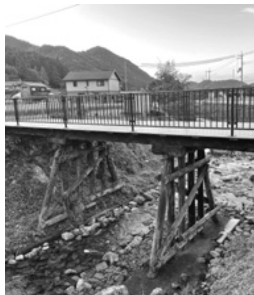
釜之内橋（田口地区）
