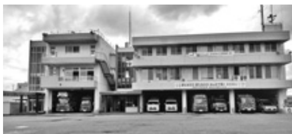
老朽化が著しい庁舎（中播消防署本署）
