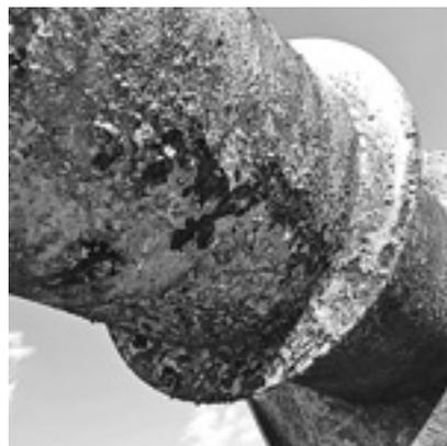
水道管の腐蝕状況
