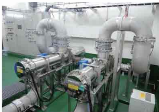
図2.3-5 福田水源地の高度浄水処理施設(左:急速ろ過設備、右:紫外線処理設備)
