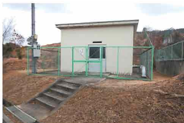
図3.3-8 東部工業団地加圧ポンプ所
