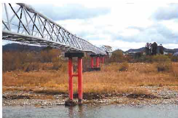
図3.3-7 八反田水管橋
