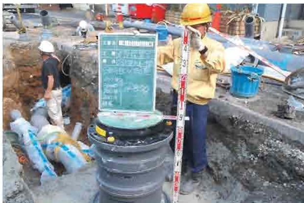
図3.3-12 管路更新工事の様子
