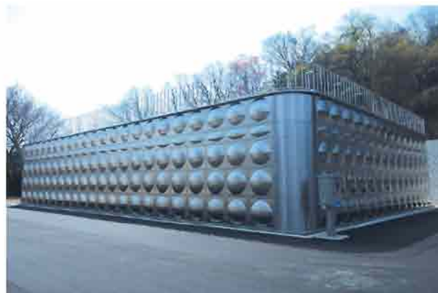
図3.3-4 工業団地配水池
