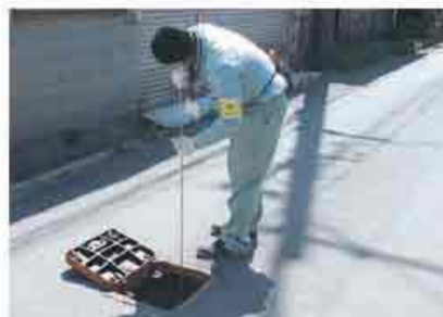
図3.4-5 漏水調査の様子
