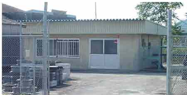
図3.2-7 井ノ口水源地
