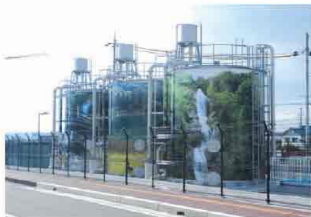
図2.3-5 福田水源地の高度浄水処理施設(左:急速ろ過設備、右:紫外線処理設備)
