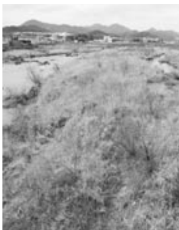
香福橋上流で進む土砂堆積
