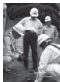
下水道マンホール調査（5月31日）
