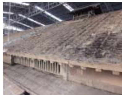
瓦を取り外した状態の屋根
