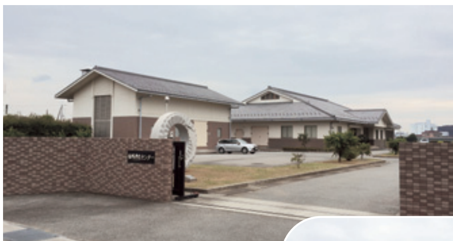
福崎浄化センター
